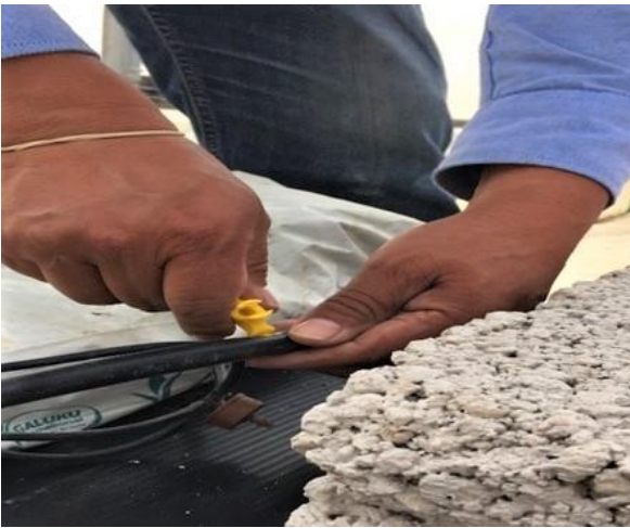
Figura 4a. Perforación de tubería
