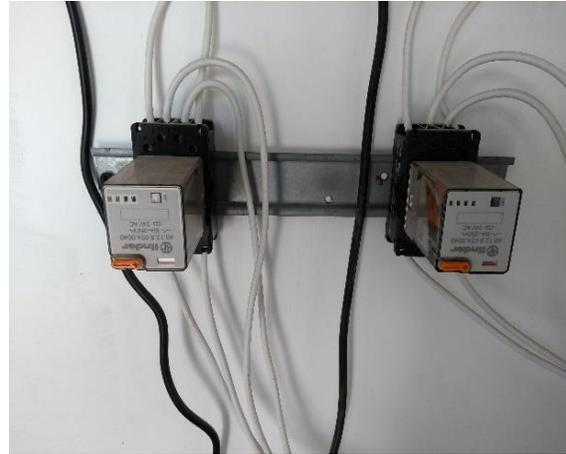
Figura 5. Relevadores que accionan las bombas de agua
