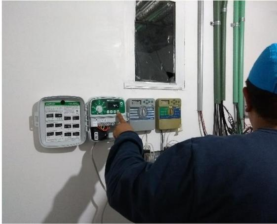
Figura 4. Controlador de riego por secciones
