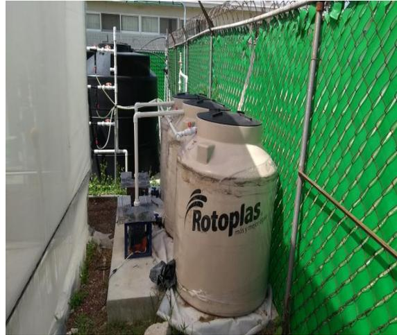
Figura 28. Bombas de agua para recirculación de solución.
