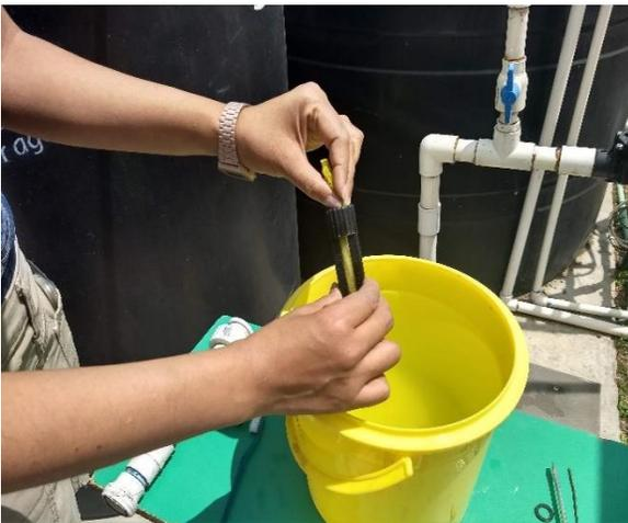
Figura 29. Lavado del inyector con un limpiapipas
