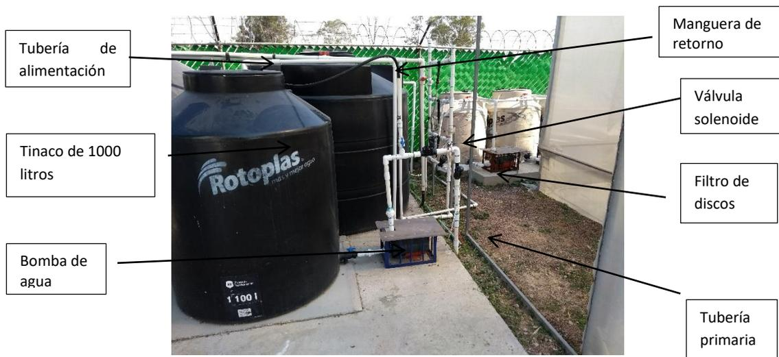
Figura 1. Sistema central de riego
