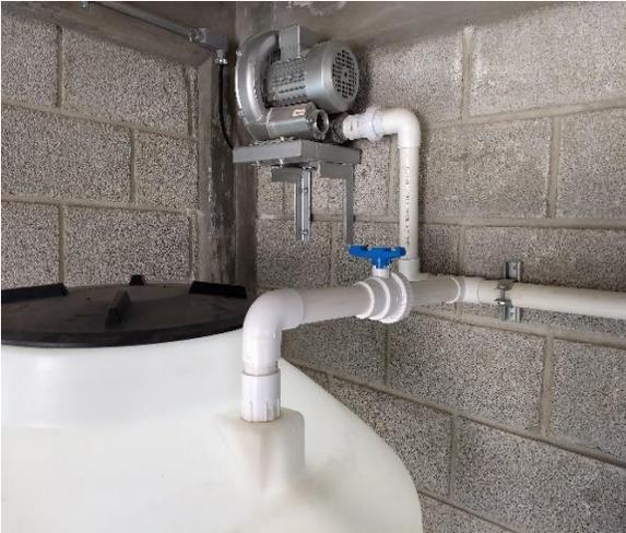
Figura 27. Agitador mecánico de soluciones nutritivas
