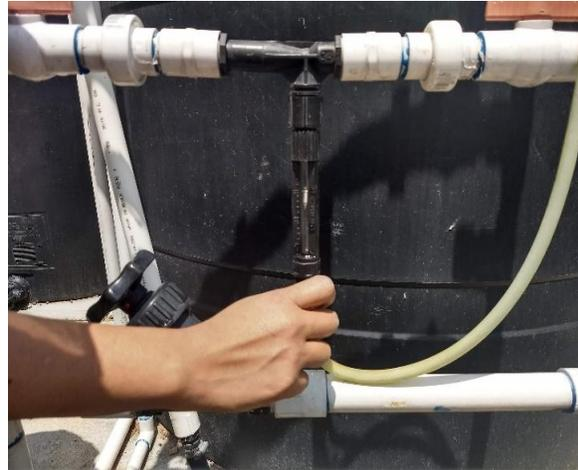
Figura 24. Calibración de inyector
