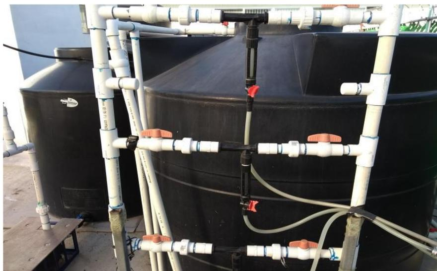
Figura 20. Inyectores de fertilizantes tipo Venturi con dosificador
