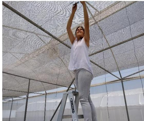
*Figura 16. Colocación de gancho con rafia en cable de acero*
