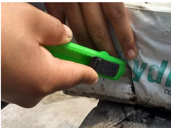
Figuras 5 y 6. Cortes en la parte inferior del boli para facilitar el drenaje del agua y sales
